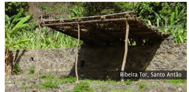
Postes de madeira, apoio de parede, coberto com palha.
