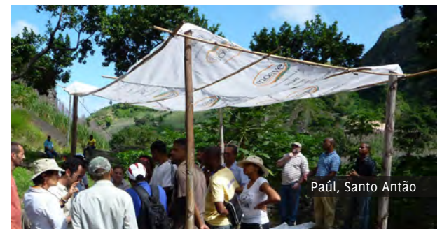
Postes de carrapate, sacos de arroz cosidos um ao outro, estrutura de bamboo. Custo de construção: 2.320$00 ECV
